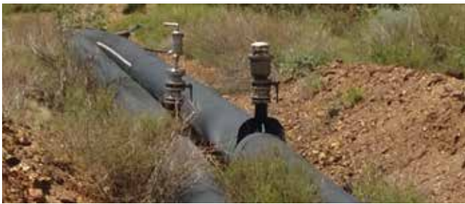
Válvulas de aire/vacío de cierre lento en aplicación de entrega de ácido
