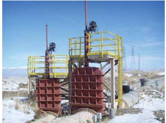
Válvulas de cuchilla de 48" y 60" con bonete y actuadores de motor, cuerpos de acero al carbono, partes húmedas en acero inoxidable 304 y revestimientos de poliuretano extraíbles para puerto en una aplicación de relaves.
