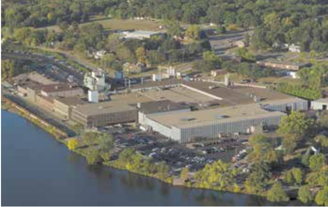
Oficina central corporativa y centro de fabricación de DeZURIK, Sartell, MN, EE.UU. Fundada en 1928, 420,000 ft 2 .
