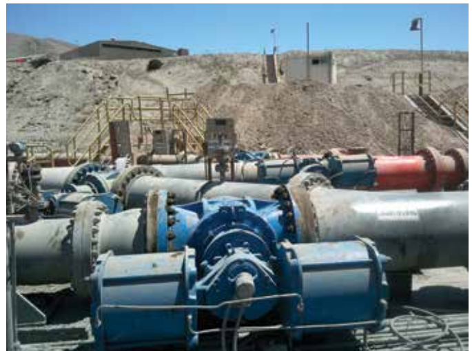
Válvula de tapón excéntrica de 24" con revestimiento de caucho en aplicación de relaves.
