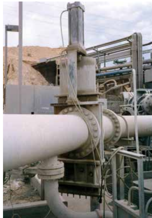
Válvula de cuchilla de puerto pasante de 30" sin bonete con construcción de acero al carbono con cilindro hidráulico y compuerta de cara endurecida en carburo de tungsteno en servicio de lodos abrasivos.
