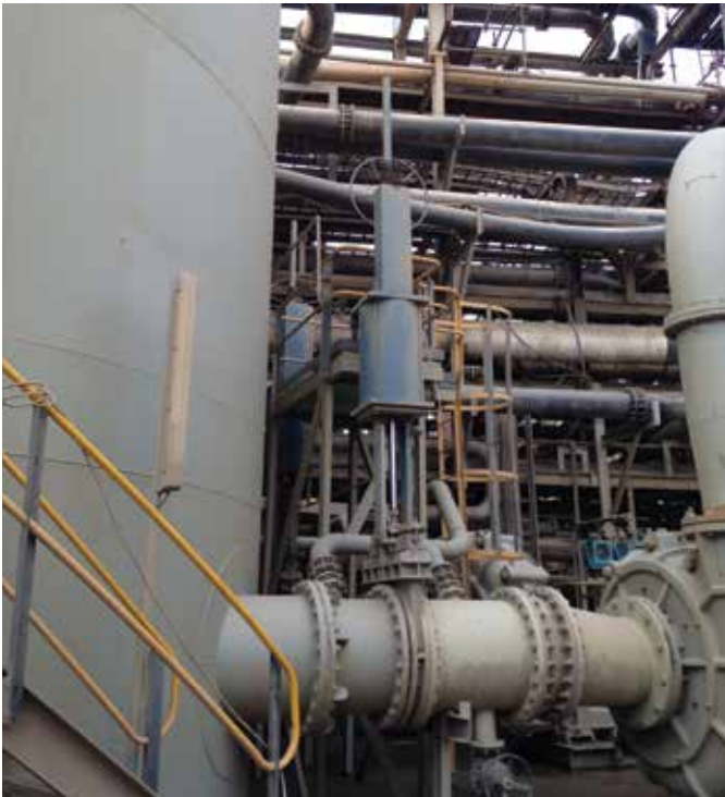
Válvula de cuchilla de servicio severo de clase de presión ASME en aplicación de bomba de succión de lodo concentrado.
